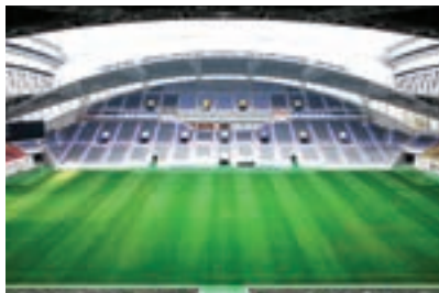
▲制振材「イーディケルM-3500SS」が採用された 「ノエビアスタジアム神戸」(ドーム屋根部分) ©神戸ウイングスタジアム
