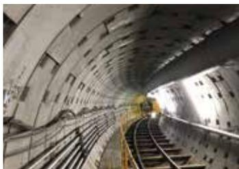
近年多発している集中豪雨等への備えとして、既存水路の流下能力を補完するとともに、管内に雨水を一時貯留させる機能により、浸水被害の軽減を目的とした大口径雨水幹線の設計事例(泥土圧シールド工法、仕上り内径φ3,500mm延長L=1.5km)です。
