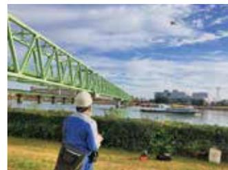
2021年に発生した和歌山市の水道橋崩落事故により、改めてインフラ施設の点検調査の重要性が認識されました。当社では下水道水管橋の老朽化点検調査にあたり、高解像度カメラを取り付けたドローンによる目視調査を実施し、従来の目視調査に比べて安全性・工期・判定精度などにメリットを得ており、今後もドローンの利活用を進めていきます。
