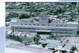
1987年6月 BML総合研究所 事務センター竣工
