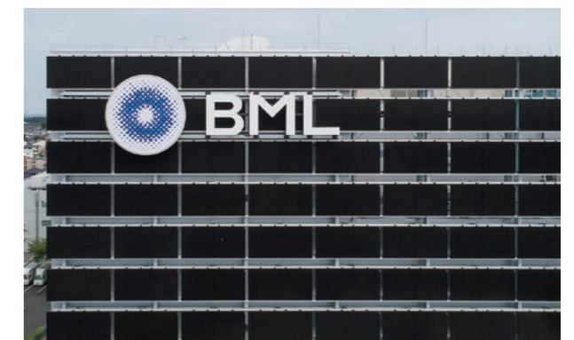
太陽光パネル
