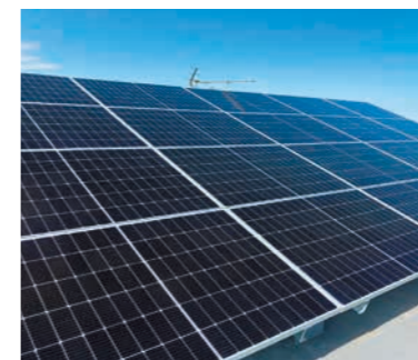
屋上に太陽光パネルを設置
