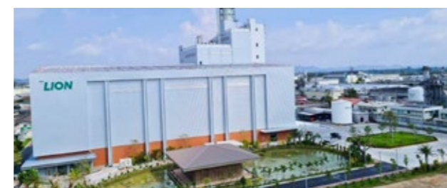
タイライオン新乾燥塔建屋の外観写真
