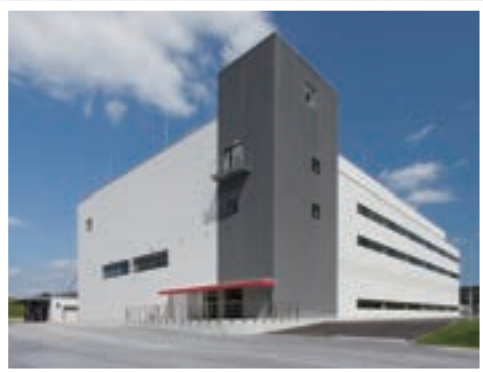
平成27年に竣工した西日本工場
