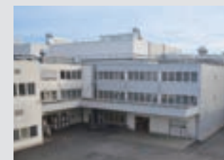
増設された工場の外観
