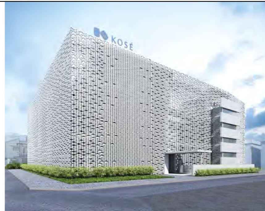
2019年3月竣工予定の「先端技術研究所」(東京都北区)
