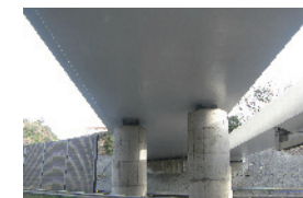
コンクリート表面保護
