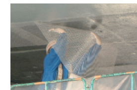
連続繊維シート補強
