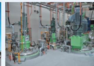
ベース製造・貯蔵タンク
