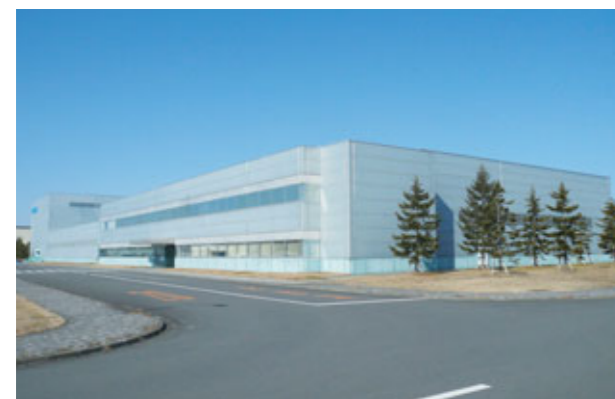
国内主力工場の例（仙台小林製薬）
