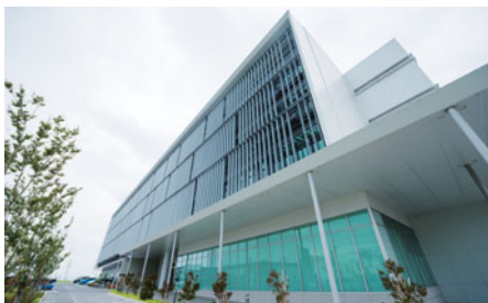
ライフラインセンター外観
