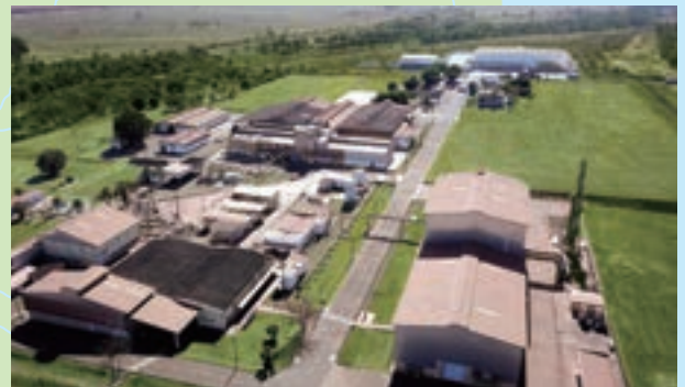
SNBウベラバ工場全景
