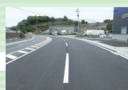
アスファルト舗装
