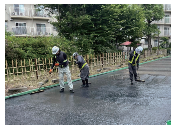
人力による施工状況
