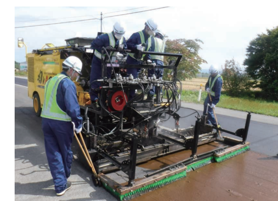
専用車両による敷き均し状況
