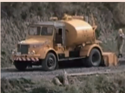
1 路上混合式工法で砂利道を舗装に変える「カチオゾール」
