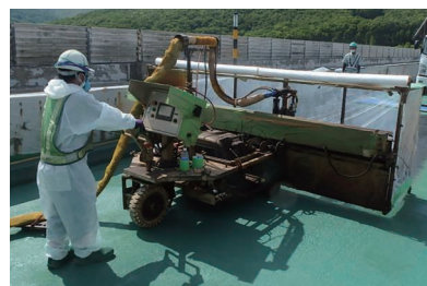
バインダ散布ロボットを活用したHQ/ハイブレンAU工法
