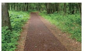
アスウッド舗装
