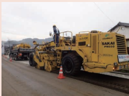
6 ICT技術を活用したロードスタビライザによる「スタビセメントRC工法」
