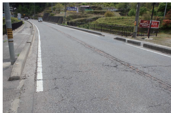
破損が進行した既設舗装
