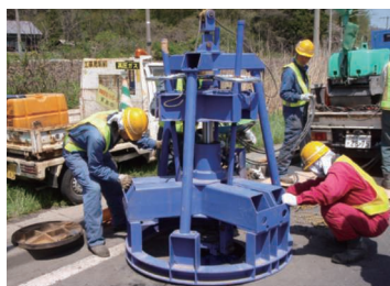
施工状況(マンホールの撤去)
