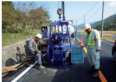
MR 2 リムーバ施工状況
