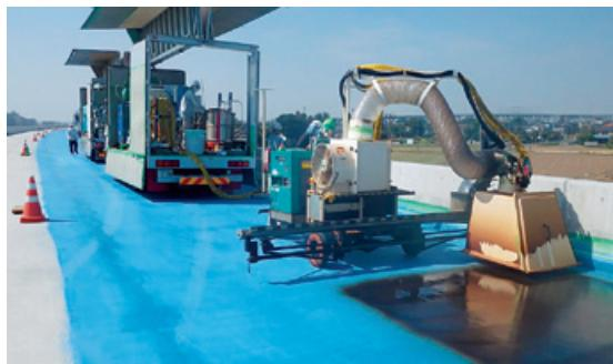
HQハイブレンAU工法 自動散布による施工
