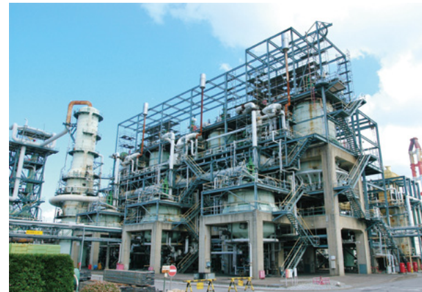
減圧残油熱分解装置(ユリカ装置)
