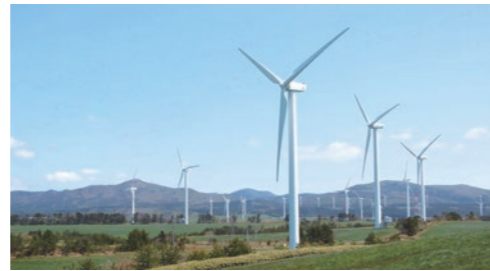
六ヶ所村二又風力発電所 2.0万kW (持分容量) 二又風力開発 (株)
