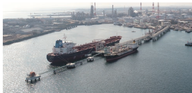
災害時受け入れ能力強化を見据えた海上棧橋強靱化（昭和四日市石油（株）四日市製油所）
