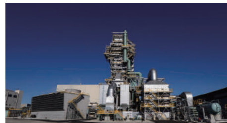
京浜バイオマス発電所 4.9万kW (株)京浜バイオマスパワー
