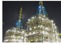
川崎天然ガス発電所
