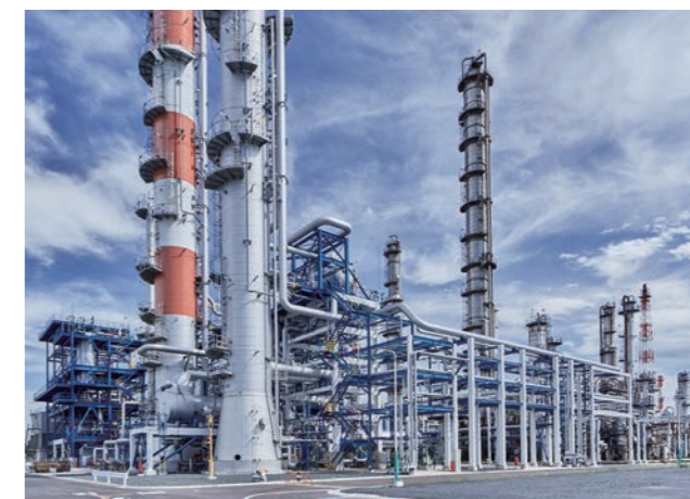
プロピレン精留塔
