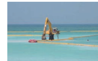
シルトカーテン設置作業
