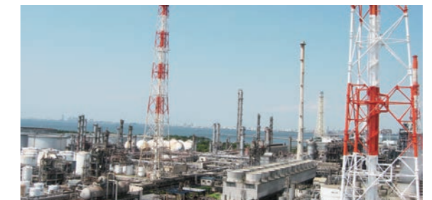
丸善石油化学千葉工場の様子
