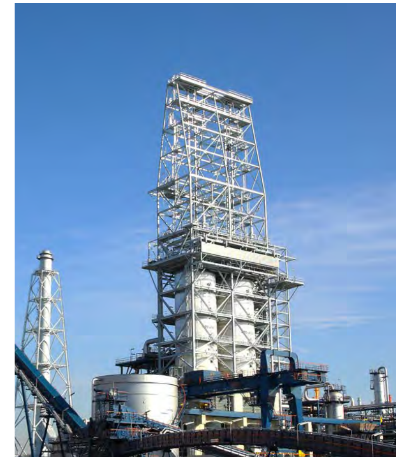
コーカー(重質油熱分解装置、堺製油所)
