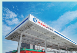
岩谷コスモ水素ステーション平和島
