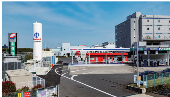
岩谷コスモ水素ステーション平和島
