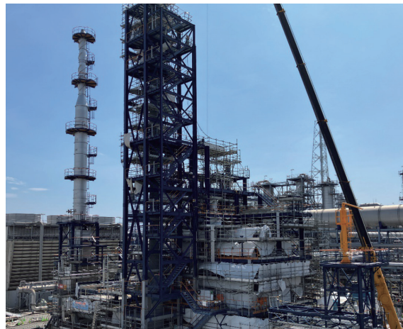
建設中のSAF製造装置（2024年7月19日撮影）
