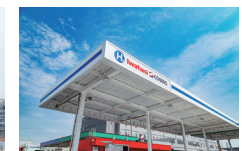
岩谷コスモ水素ステーション平和島
