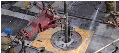
掘削作業中のリグ
