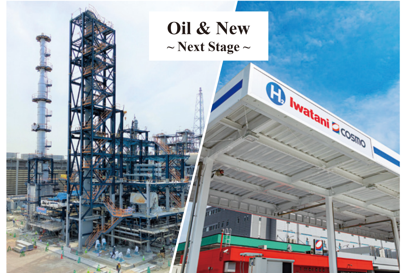
建設中のSAF製造装置
