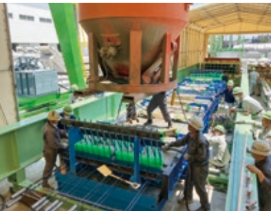
プレストレス道路床版試作状況
