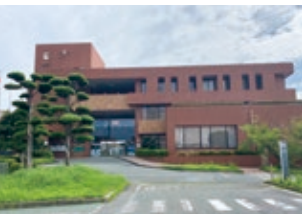
福津市役所 (福岡県福津市)
