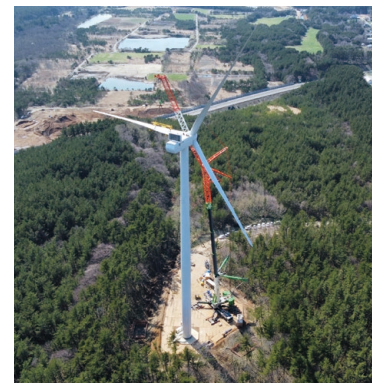
風車施工の様子
