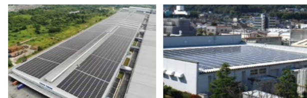
マレーシアのタイヤ工場屋上
