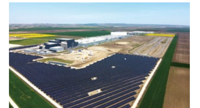
セルビア工場の太陽光発電システム
