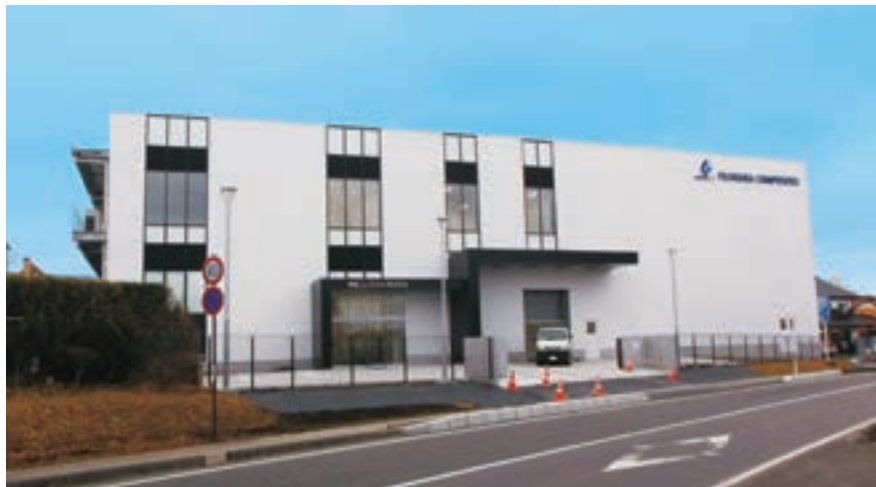
福島県南相馬市にあります原町工場内LIM棟のクリーンルームで医療関係製品の製造を行います。
