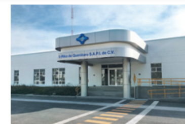
※1 稼働を開始したメキシコのS-Riko de Querétaro, S.A.P.I. de C.V.第2工場
