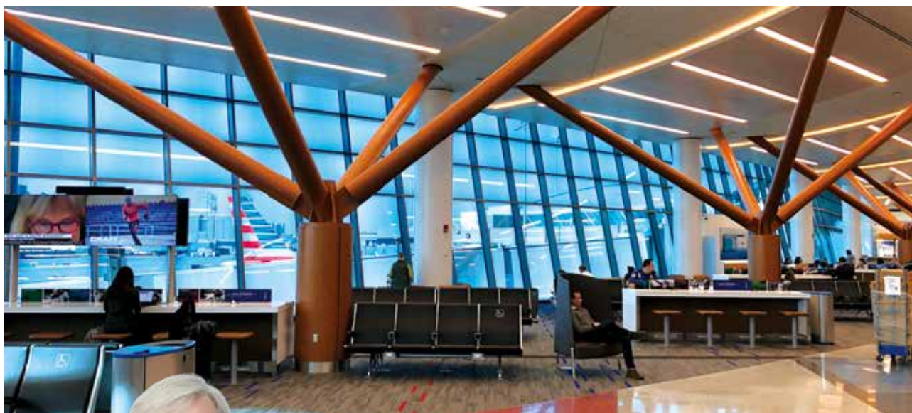
ボストンのローガン空港に設置されたView社製調光ガラス(NSG TEC™使用)
