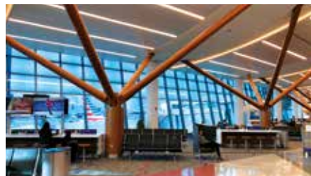
ボストンのローガン空港に設置されたView社製調光ガラス(NSG TEC™使用)
