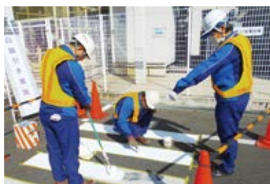
事業場構内の白線引き作業
