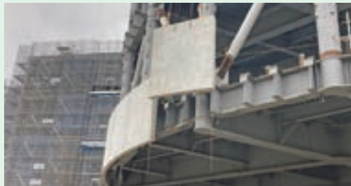
ランプ棟PCa腰壁 施工写真 (大阪府和泉市)
