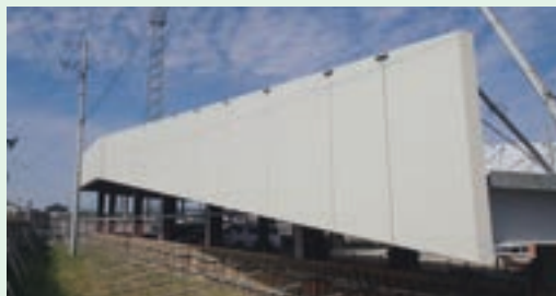
車路PCa腰壁 施工写真 (愛知県江南市)
