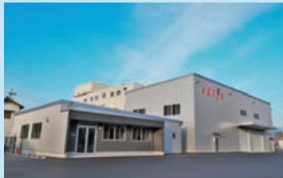
株式会社YCK施工事例（株式会社アクティオ様 静岡営業所）
