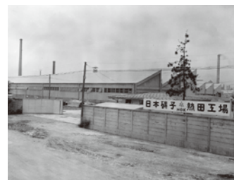
1957年の本社・熱田工場の完成で世界一のガイスメーカーへの足場を固めた
