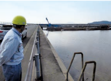
産廃処分場現地確認
