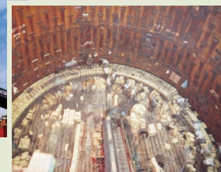
耐火物施工事例 ①高炉
