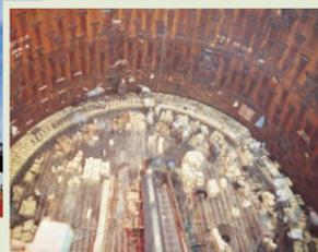
耐火物施工事例 ② コークス炉
