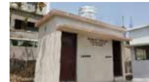
トイレ設置による地域衛生化とより良い街づくり
