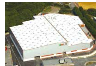
Krosaki Amr Refractorios, S.A. 新工場 更なるグローバル生産体制強化に向けて欧州に新工場を立上げ
