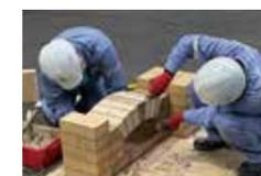
築炉試験練習による技能伝承
