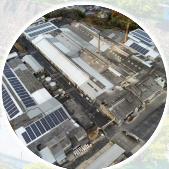
瑞浪工場の太陽光発電設備(2022年11月稼働)
