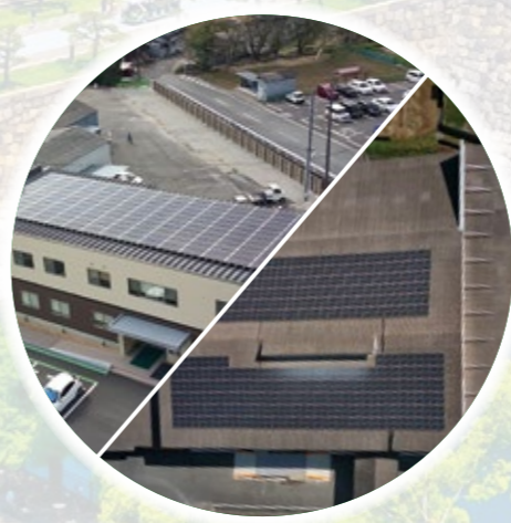
吉永工場の太陽光発電設備 (第一製造所:2023年8月稼働、第二製造所:2021年6月稼働)
