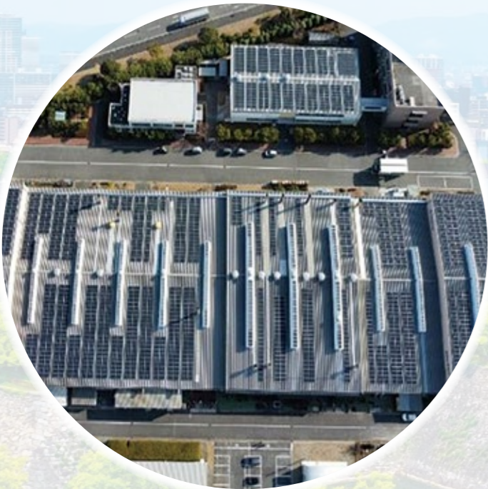
貝塚工場の太陽光発電設備(2022年2月稼働)
