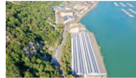
日生工場(西工場・東工場) 2024年1月稼働/太陽光パネル数: 1,548枚(624kWh)
