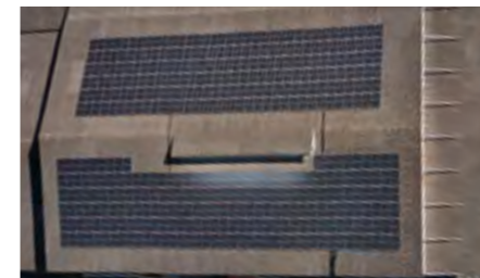
吉永工場(第二製造所) 2021年6月稼働/太陽光パネル数: 423枚(150kWh)
