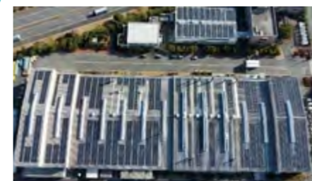
貝塚工場 2022年2月稼働/太陽光パネル数: 2,022枚(748kWh)
