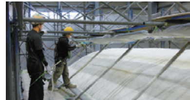
大手造船タンクメーカー殿でのLNG燃料タンク保冷工事の状況
