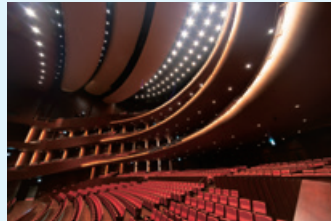
天井 エフジーボード
