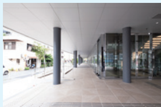
外部天井 ハイラックフネン
