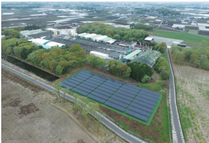
(株)イーアンドエー茨城太陽光発電全景
