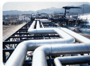
LNG保冷配管工事
