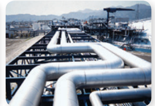
LNG保冷配管工事
