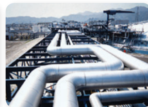
LNG保冷配管工事
