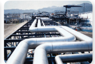
LNG保冷配管工事
