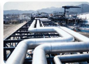
LNG保冷配管工事
