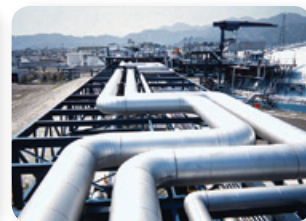
LNG保冷配管工事
